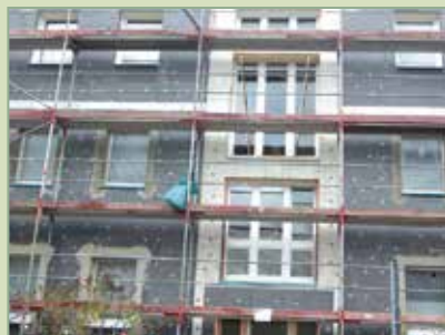
Einbau Brandriegel
