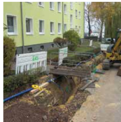
Erneuerung der Hauptwasserleitung in der Blankenhainer Straße
