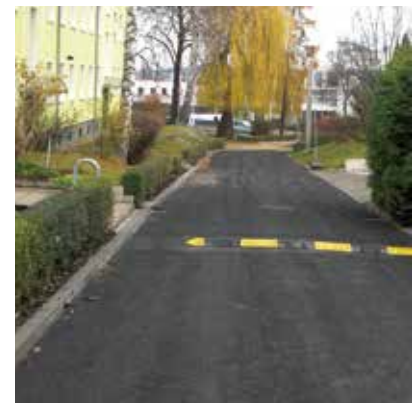
Die Zufahrt der Blankenhainer Straße nach der Fertigstellung
