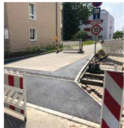
Erneuerung der Garagenauffahrt Hans-Grundig-Straße
