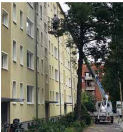
Fassadenreinigung in der Friedrich-Engels-Straße
