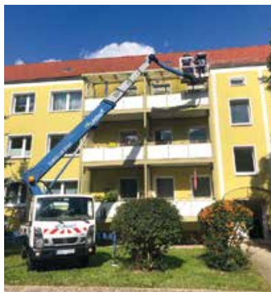
Reinigung der Balkonabläufe und Verschließen der Spechtlöcher
